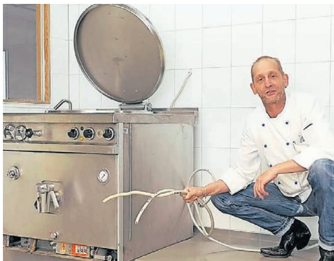
Derzeit wird in der Tafelküche fleißig umgebaut. Uwe Lattkus vom Küchenteam gehört ebenfalls zu den tatkräftigen Helfern.
