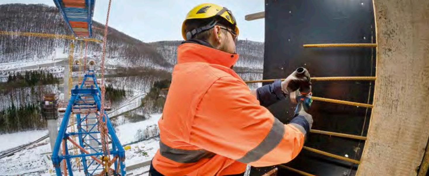
den heutigen Einsatz besprochen und die Aufgaben festgelegt: 160 Tonnen Bewehrungsseisen müssen schnellstmöglich verlegt werden, damit der Beton gegossen werden kann. „Die Bewehrungsführung ist sehr eng. Wenn Positionen nicht passen, müssen die Eisen mit Winkelschleifern gekürzt werden. Das Team muss dafür Zubehör und Werkzeug vorbereitet
