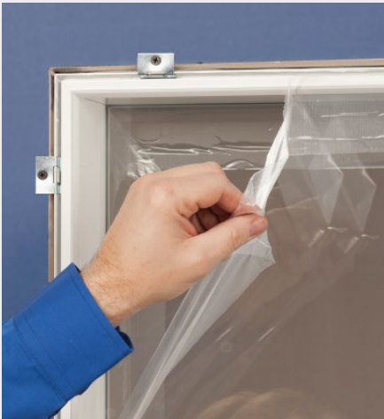
Schutzfolie entfernen
