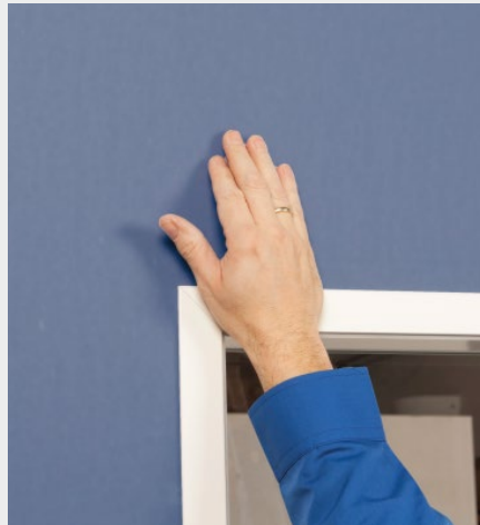
Abdeckrahmen einsetzen
