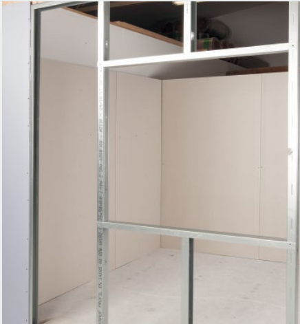
Öffnung für Fertigfenster herstellen
